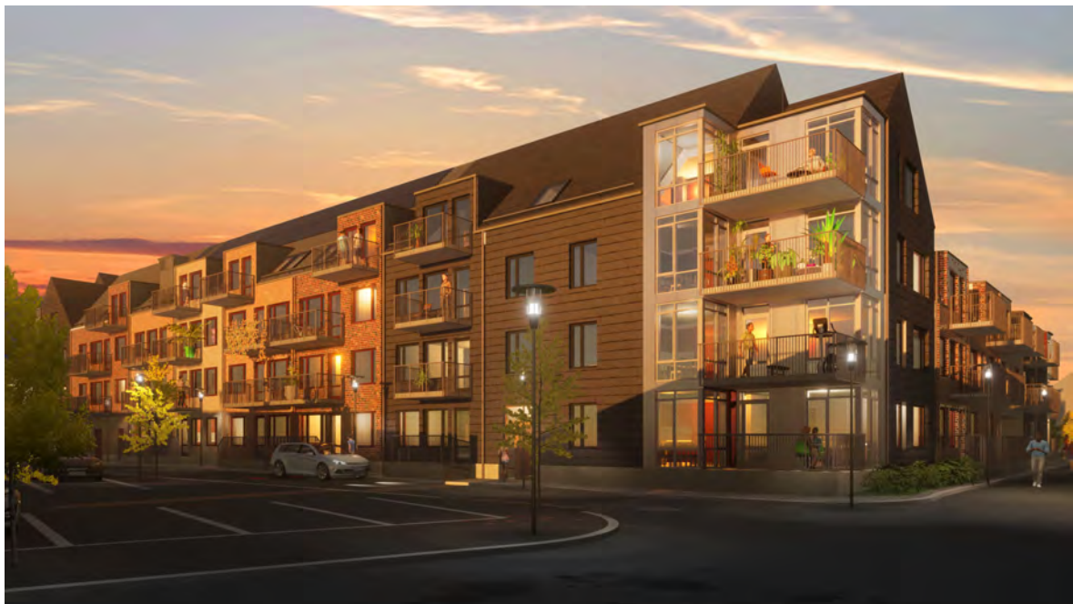
Byggnaden från sydväst i skymning
